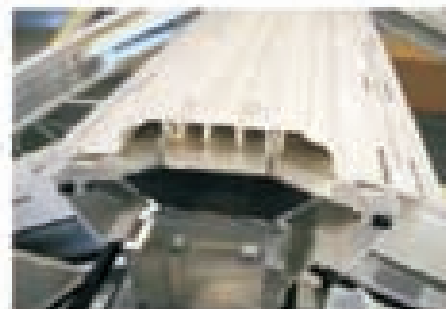
Nakładka jest w prawidłowej pozycji kiedy skrzydła nakładki są w kontakcie ze skrzydłami kalenicy.
