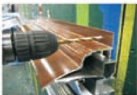
Wytłoczona jest linia wzdłuż tylnej ścianki aluminiowej nakładki namurnicy. To jest linia w której zakłada się wkręty do mocowania.
