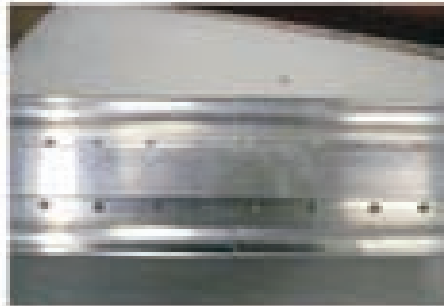
Widok dolnej części kalenicy łączonej używając 8 sztuk śrub nr XM48-13.
