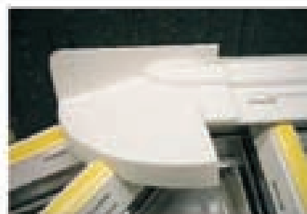
Dachy pulpitowe zakończone częścią promieniową mają założone na końcu nakładkę promieniową. Ta nakładka powinna być uszczelniona i przymocowana do nakładki namurnicy za pomocą plastikowych nitów, które są dostarczone.
