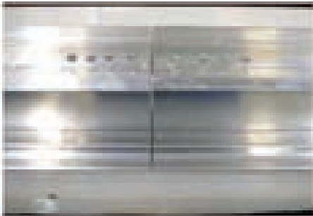
Założ drugą stronę kalenicy na łączniki i zabezpiecz jak poprzednio.
